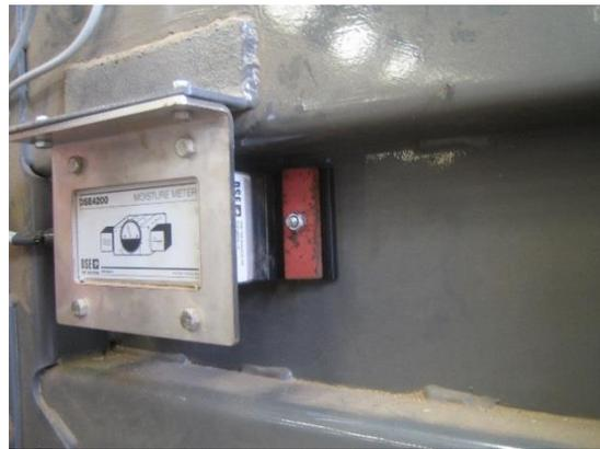
Die Abbildung unten zeigt das Innere des Kanals. Der an die Wand angeschweißte Metallstreifen vor dem Sender/Empfänger verringert die Anhäufung von Material im Umkreis der Geräte und somit die Gefahr von Beschädigungen.
